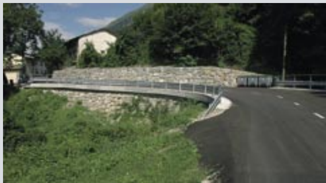
Sanacija podpornega zidu Potoki
